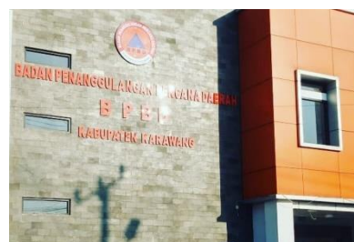
Gambar 1. Gedung BPBD Karawang (Dokumentasi Peneliti, 2024)
